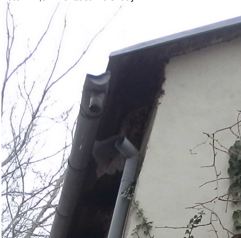
Foto č. 2,3 – nezaústěné svody
